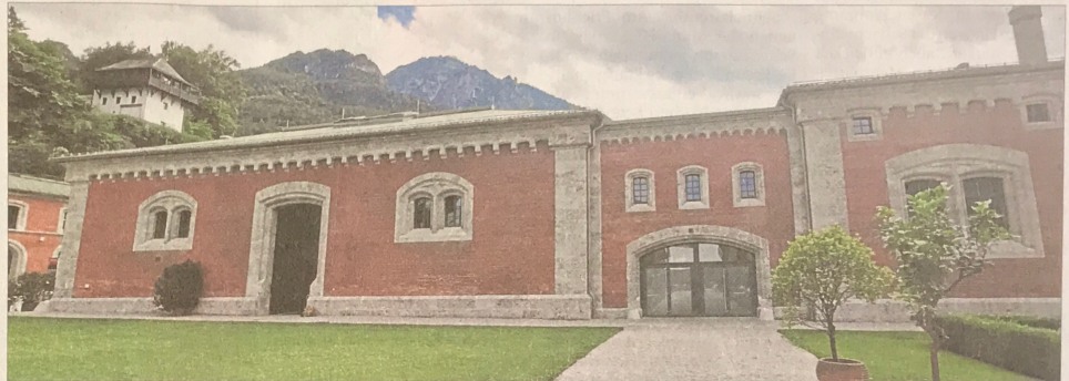
Großprojekt Alte Saline: Ein Baustein ist das Magazin 3, das im vergangenen Jahr eingeweiht wurde.
